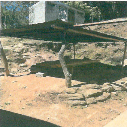
Foto 3: Reparación y sustitución de Área de Cocina.
