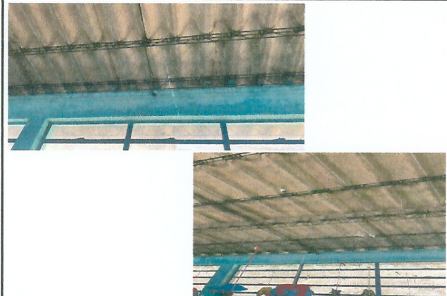
Foto 4: Cubierta de lamina
