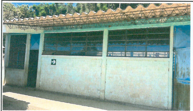
Foto 2: Pintura en muros interiores y exteriores
