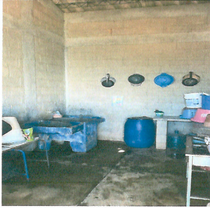
Foto 1: Reparación y sustitución de Área de Cocina
